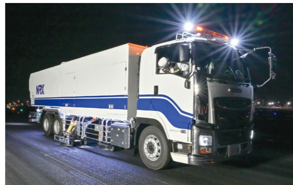
成田国際空港滑走路にて試験施工(令和8年4月22日)
