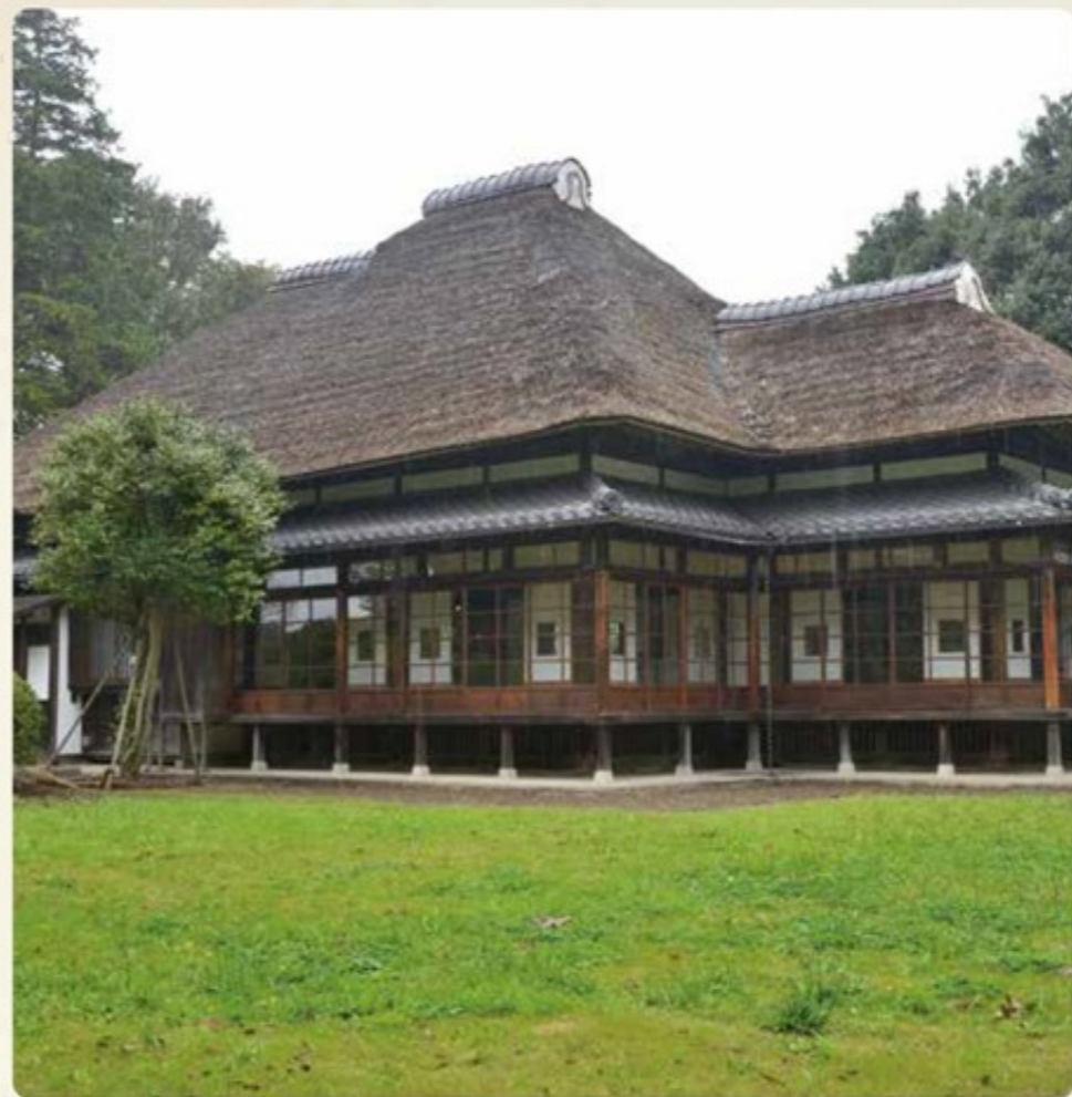
貴賓館 下総牧羊場の外国人責任者、アップ・ジョーンズの住居を1888年(明治21年)に現在地に移築したもので、後に外国の大公使を招待する園遊会の会場などとしても使用された。木造茅葺の平屋建てで、外見は和風だが、内装はギリシャ風の豪華なホールなど、和洋折衷様式を取り入れた貴重な建物
