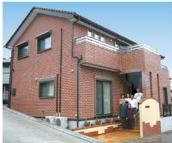
約6カ月の工期で完成しました!
