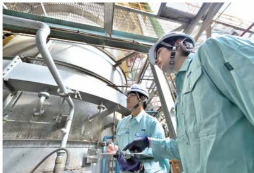
焼却炉に異常がないかなど、各プラント設備機器を定期的に巡回し目視により確認する
