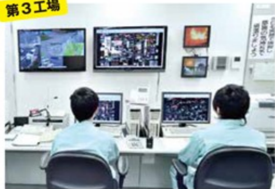
中央操作室では全処理工程の管理を自動で行うことができる最新システムを導入
