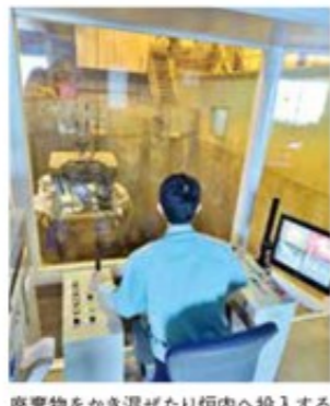
廃棄物をかき混ぜたり炉内へ投入する工程は、そのほとんどがオートメーション化されている
