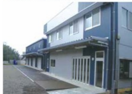
手前が事務所棟、奥が倉庫棟
