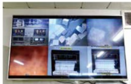
炉内の燃焼状況や廃棄物の搬送状況などを一つのモニターで確認できる
