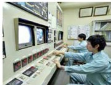
中央操作室では、焼却状態や設備機器に異常がないかチェックを行う
