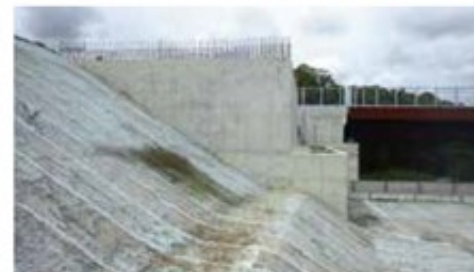
成田高速鉄道の線路に隣接する橋台
