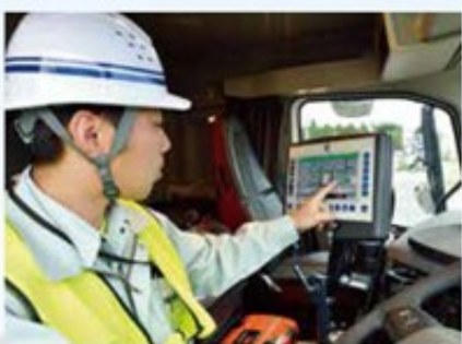
作業は、運転者と車外で状況を確認する作業員との2人1組で行う。運転者は、モニターと車外の作業員の指示に合わせて、運転席のコントロールパネルで細かく設定を行う
