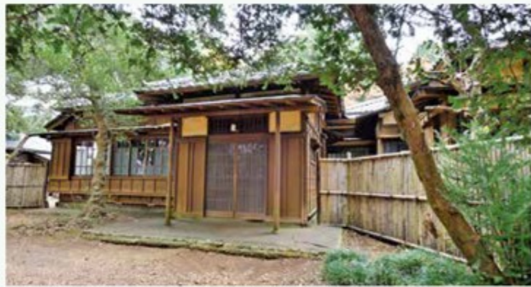
主屋は耐震構造を意識したことがうかがえる造りで、凝った外周のガラス障子など、軽快で活潑な外観となっている
