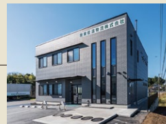
関東低温物流(株)事務所 新築工事 成田市
