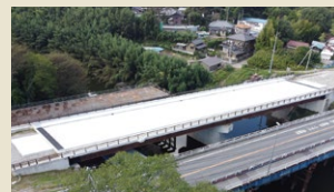
三角町柏井町線 (柏井橋) 床版工事 (2-4) 千葉市
